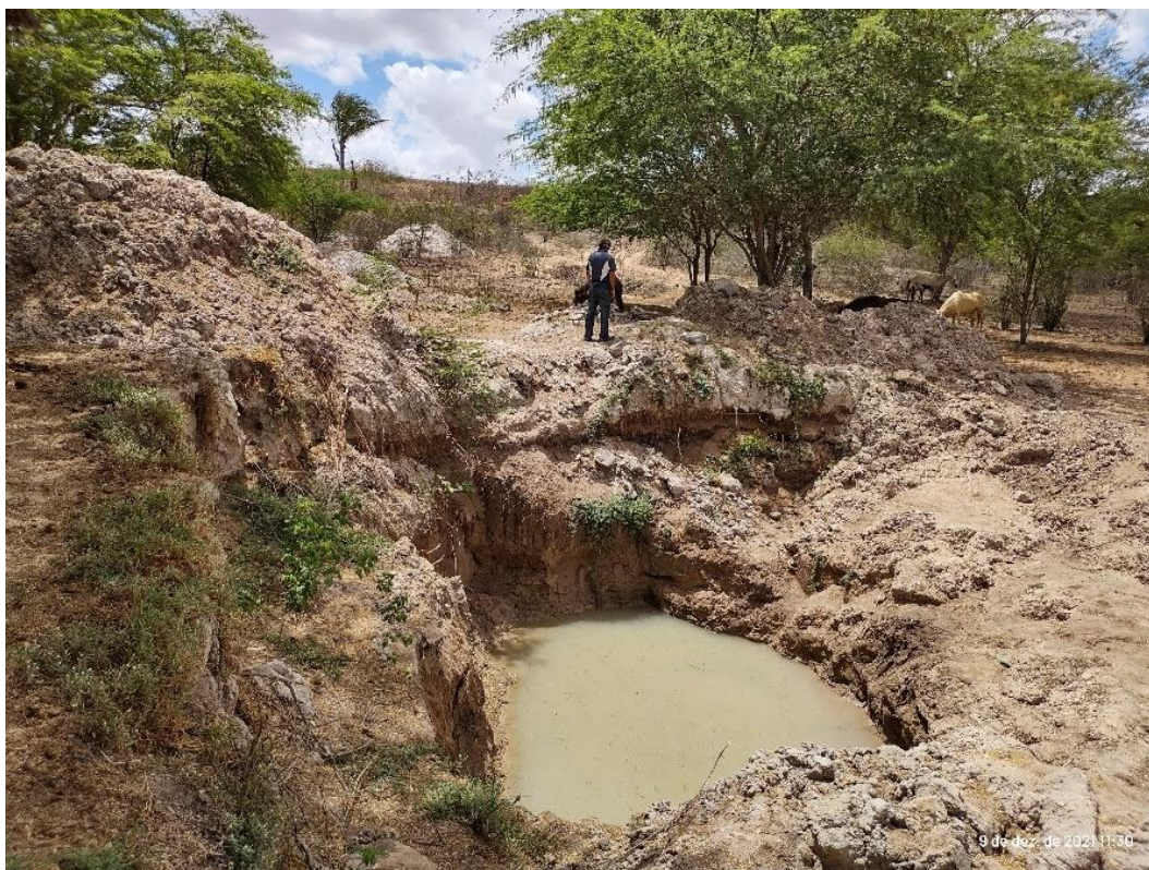
Figura 2.75: Açude presente no leito da drenagem constante no ponto F133 (coordenadas UTM 25S 187344/ 9272919).
