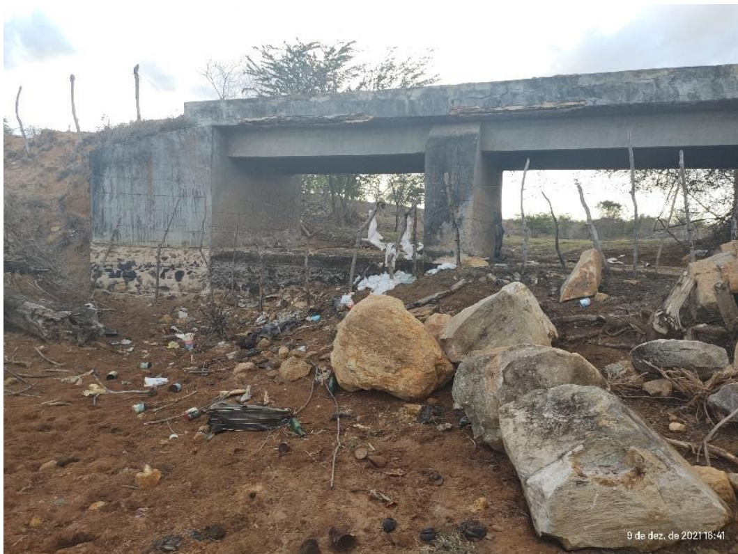
Figura 2.78: Drenagem constante no ponto F149 com presença de ponte (coordenadas UTM 25S 194366/ 9272287).
