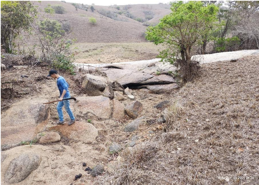
Figura 2.93: Drenagem intermitente e lagoa a jusante no ponto F261 (coordenadas UTM 25S 199357/ 9279849).
