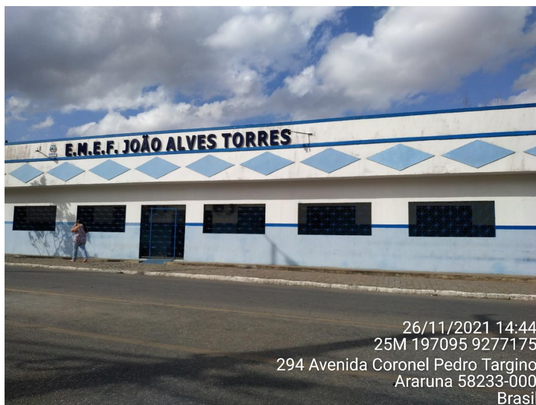
Figura 2.186: E.M.E.F João Alves Torres localizada no centro de Araruna.
